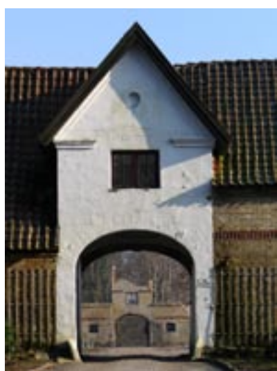
Mattrup avlsbygninger under nedbrydning
