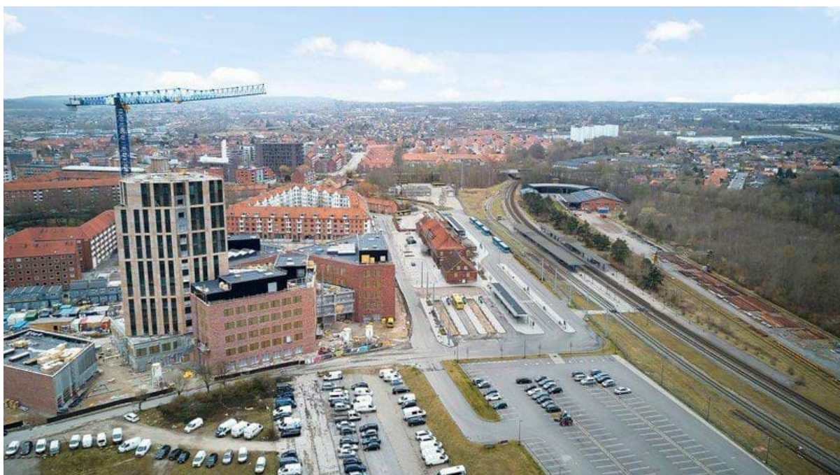
Kig mod Campus under opførelse, Horsens Trafikterminal og Banegården.
