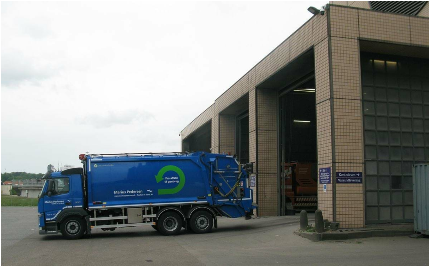
Billedet viser forbrændingsanlægget på Endelavevej i Horsens.
