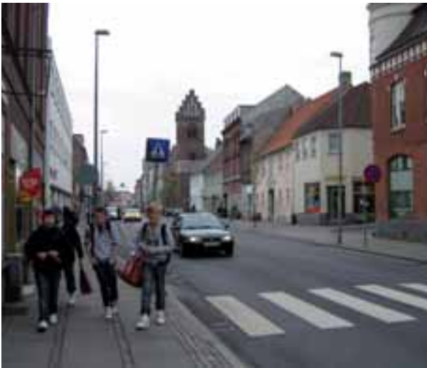
Nørregade har potentiale til at blive en central gade i Horsens midtby, men idag fremstår den nedslidt, og gåmiljøet er for uattraktivt.
