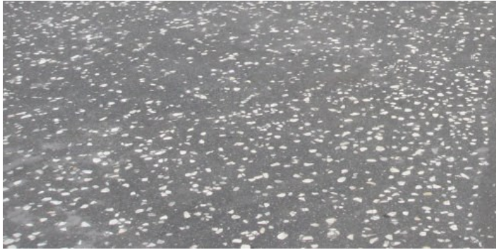
Asfalt med tilslag
