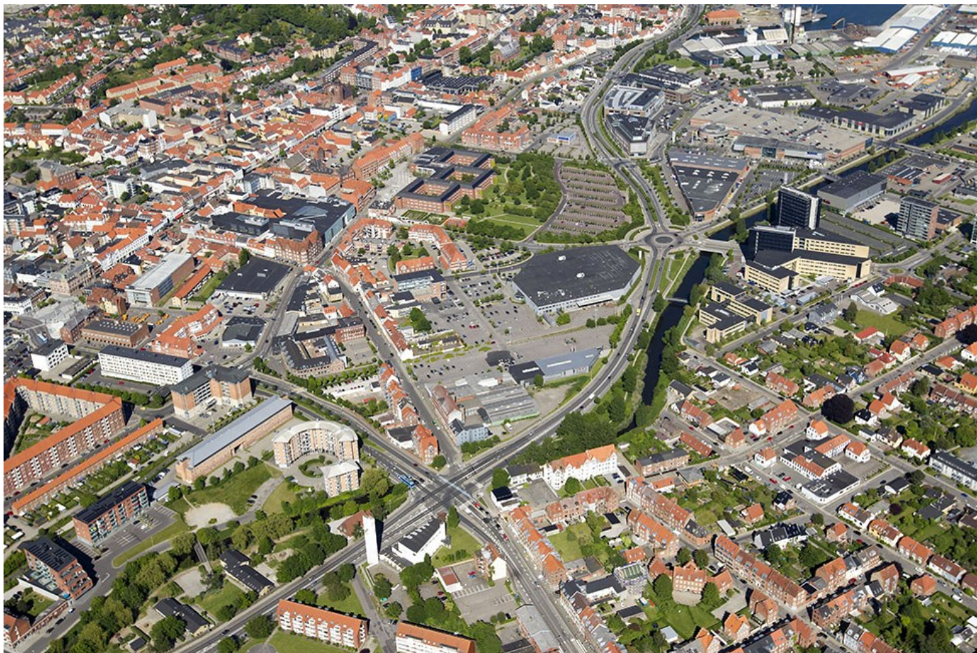
Luftfoto af den sydlige del af bymidten med den eksisterende Kviklybygning
